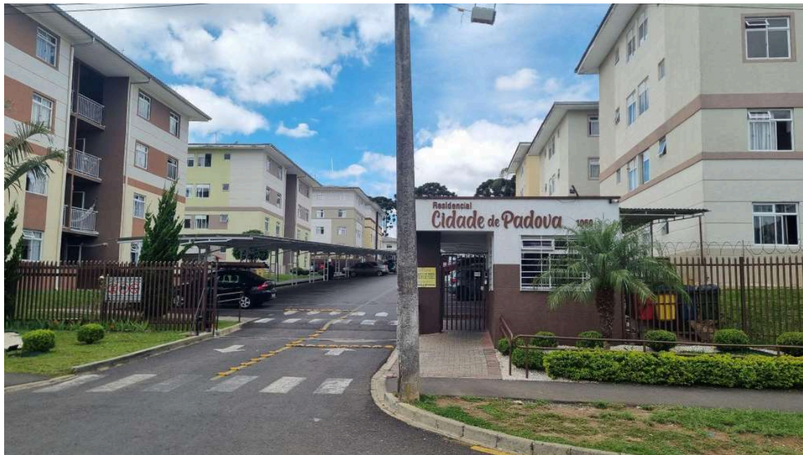
Vista do Imóvel Avaliando
