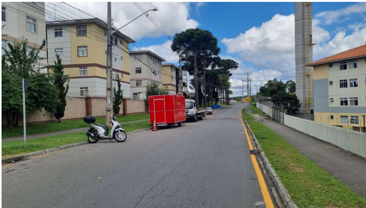
Vista à direita do imóvel
