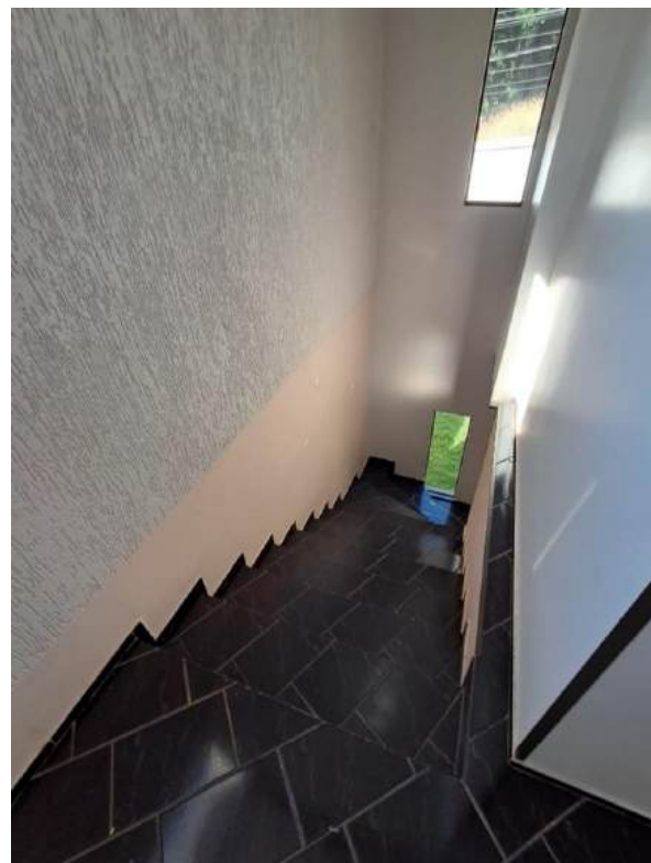
Figura 19 - Imagem local imóvel
