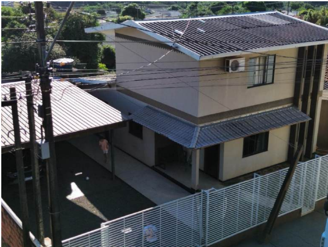
Figura 9 - Imagem local imóvel
