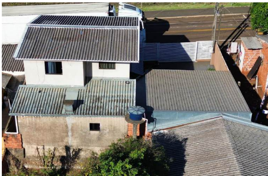
Figura 5 - Imagem local imóvel
