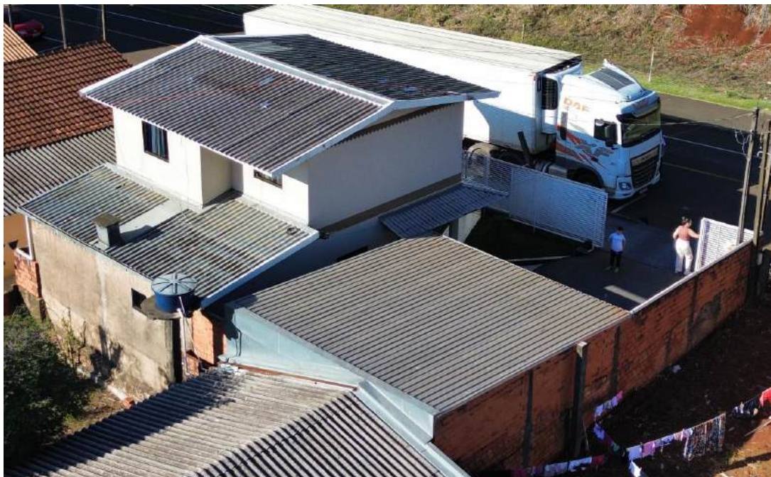
Figura 6 - Imagem local imóvel
