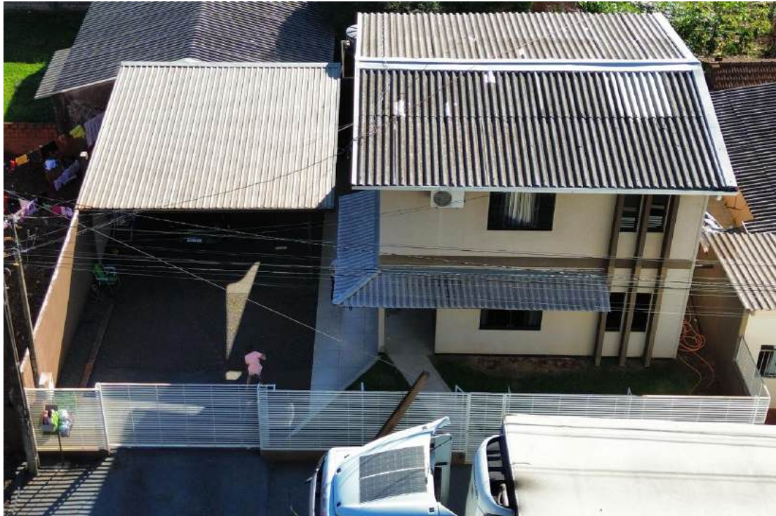
Figura 8 - Imagem local imóvel
