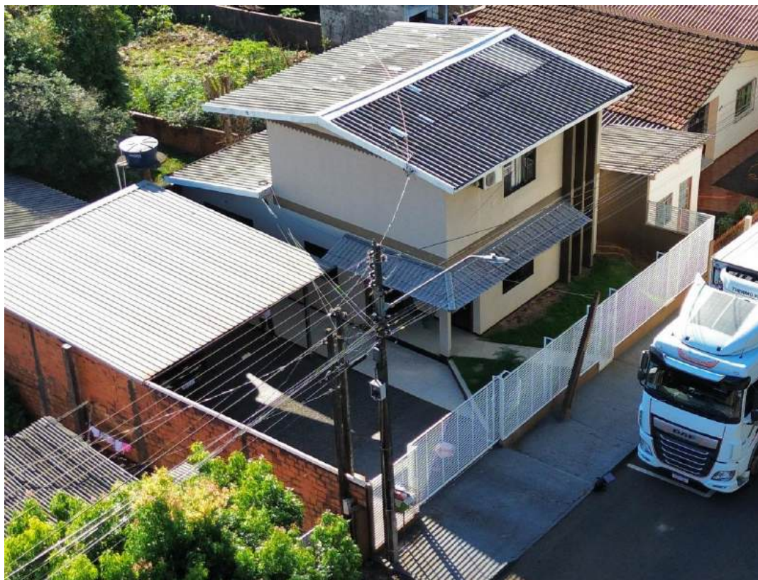
Figura 7 - Imagem local imóvel
